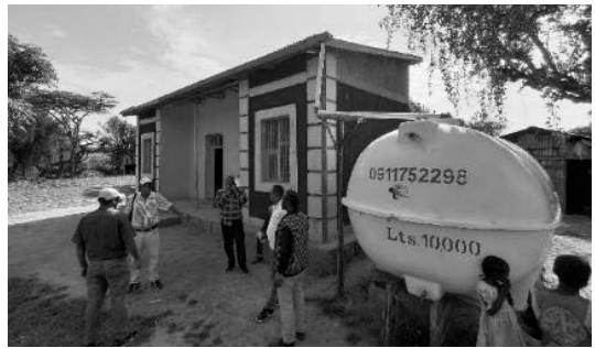
写真4 屋根水集水と水タンク(1万ℓ)
